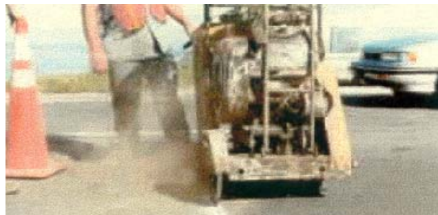
Cortadora para ranura de 19 x25 mm (fondo x ancho)
