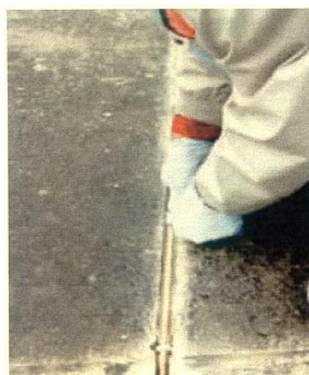
Instalando el sensor en su ranura
