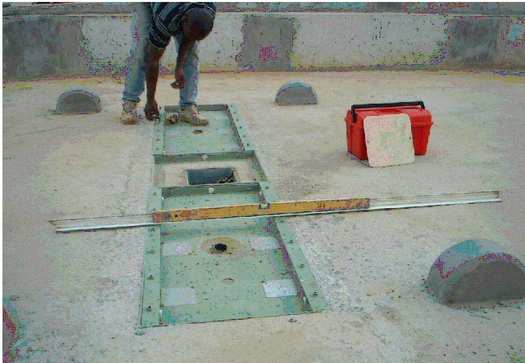
instalación de los bastidores terminada, antes de colocar las plataformas de las básculas
